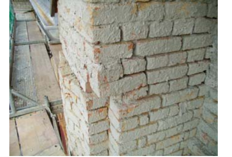
Einbausituation während Notsicherung 2009
