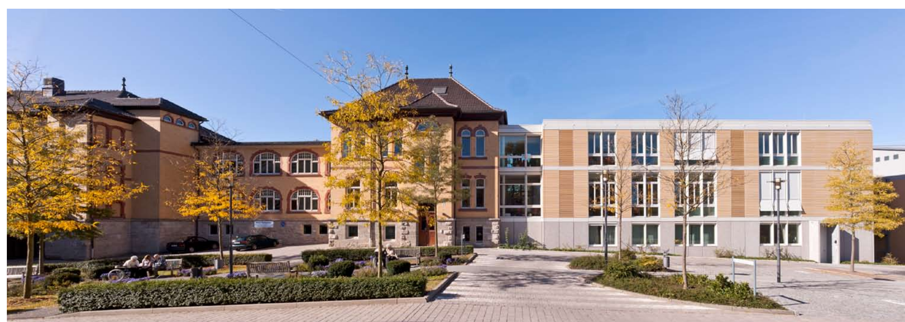
Zufahrt mit Erweiterung Bettenhaus Bauteil 1.2
