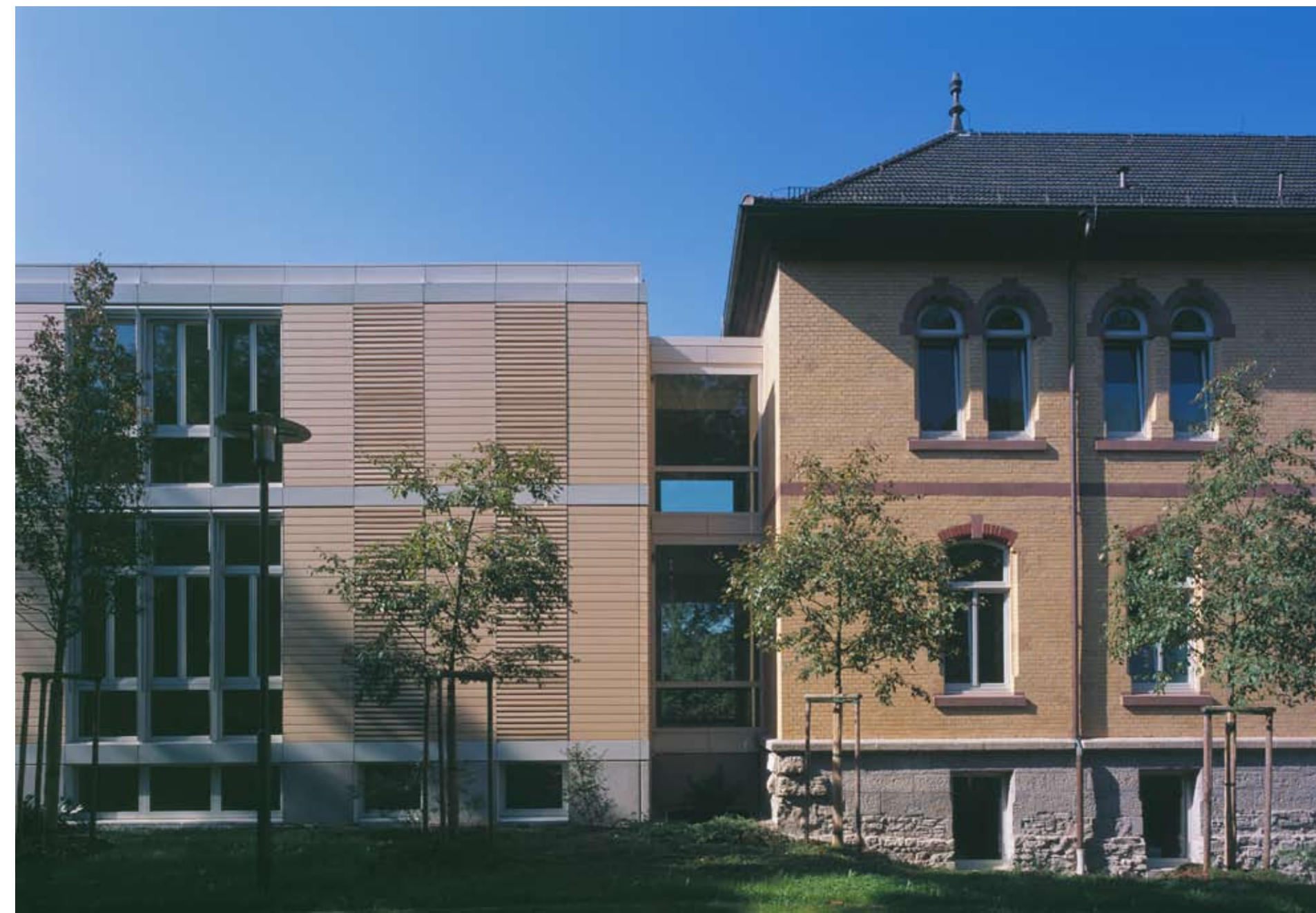
Übergang Altbau - Neubau
